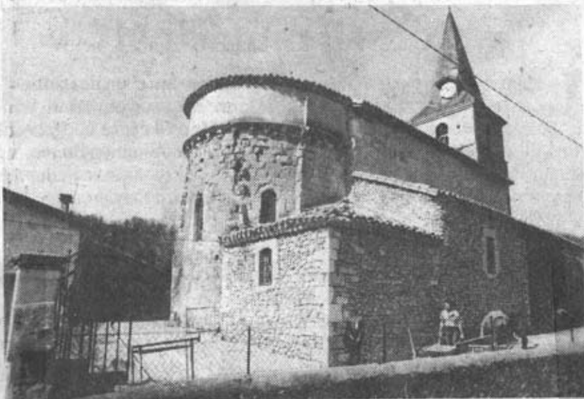
L'église du Fréchet en état de restauration.
